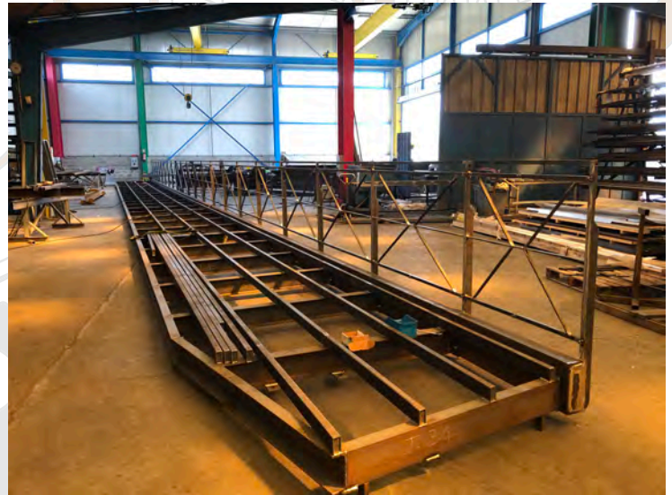
Élargissement de pont structure métallique et platelage bois ( Jouy)
