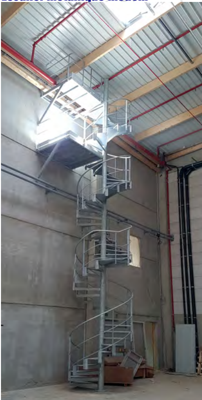
Escalier métallique (Marly)
