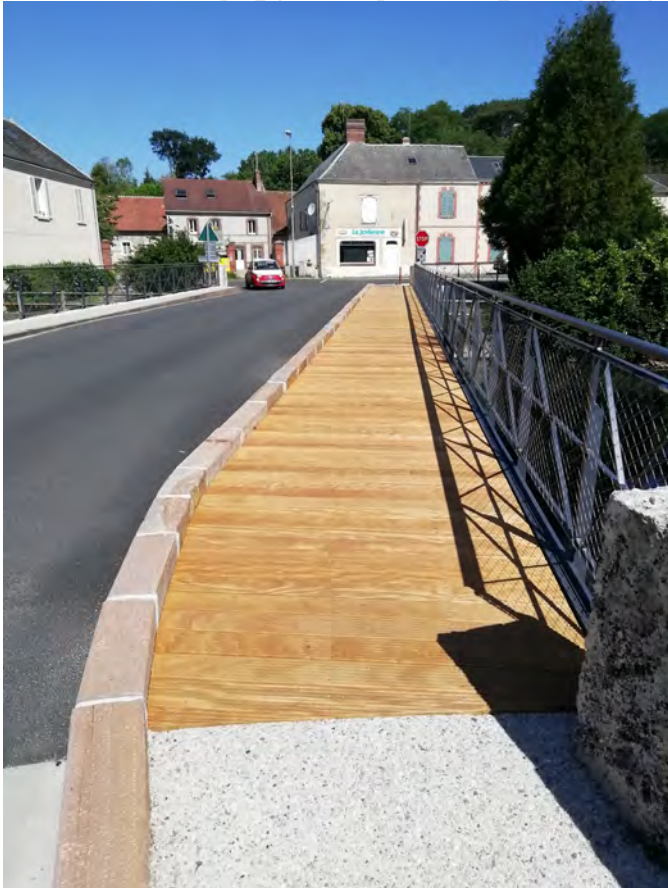
Élargissement de pont structure métallique et platelage bois ( St Lubin)
