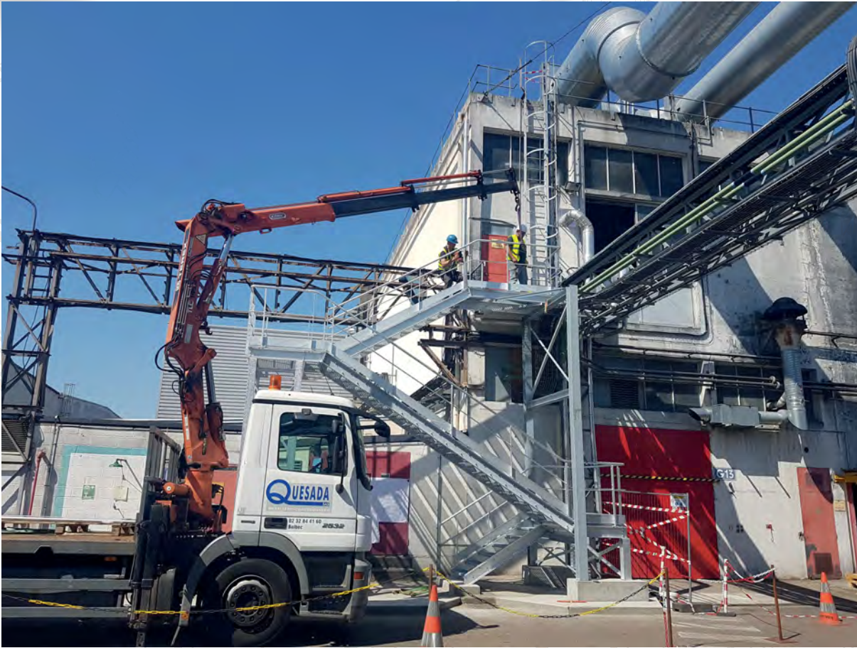
Escalier métallique (Rouen)
