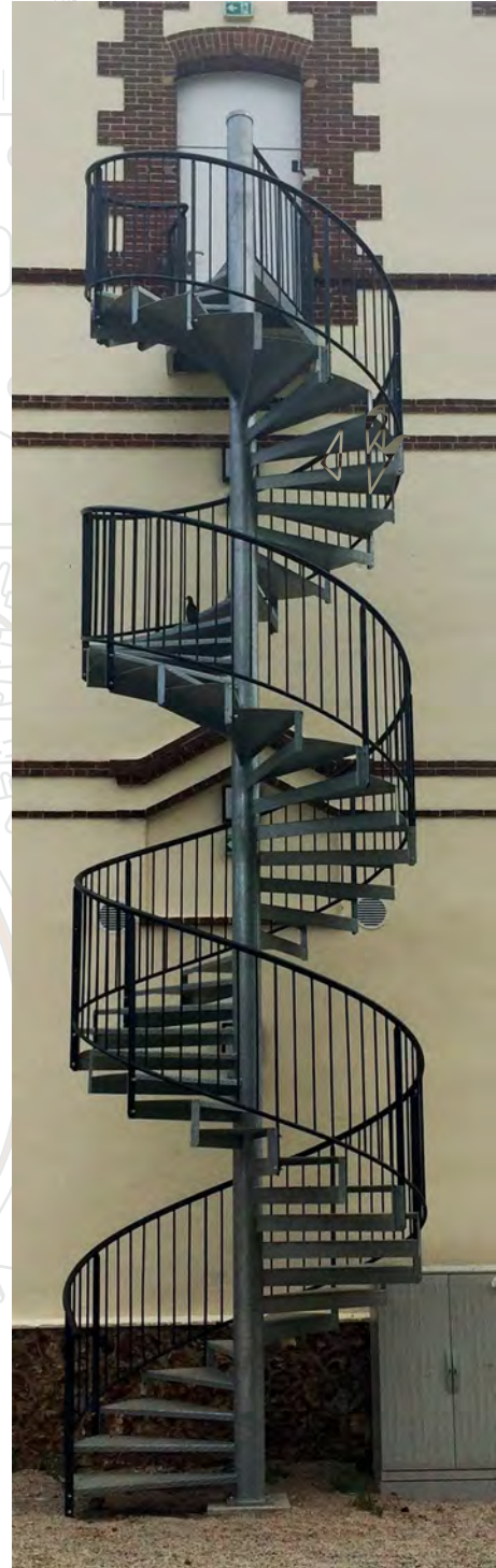
Escalier de secours 2UP (Verneuil-sur-Avre)
