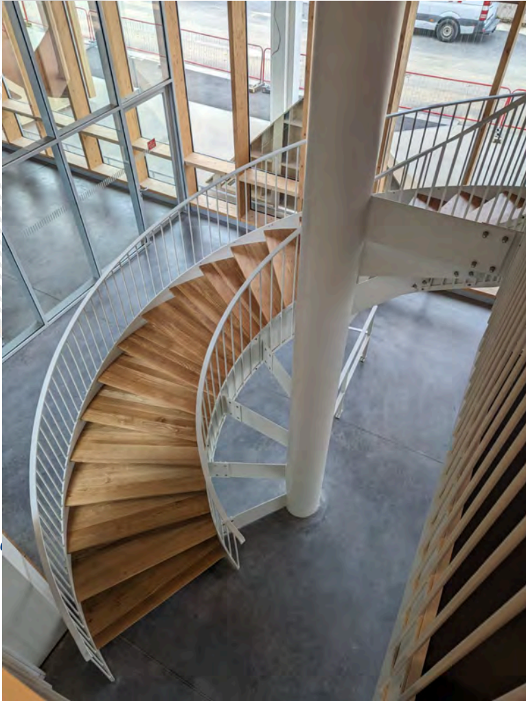
Escalier aéroport Deauville
