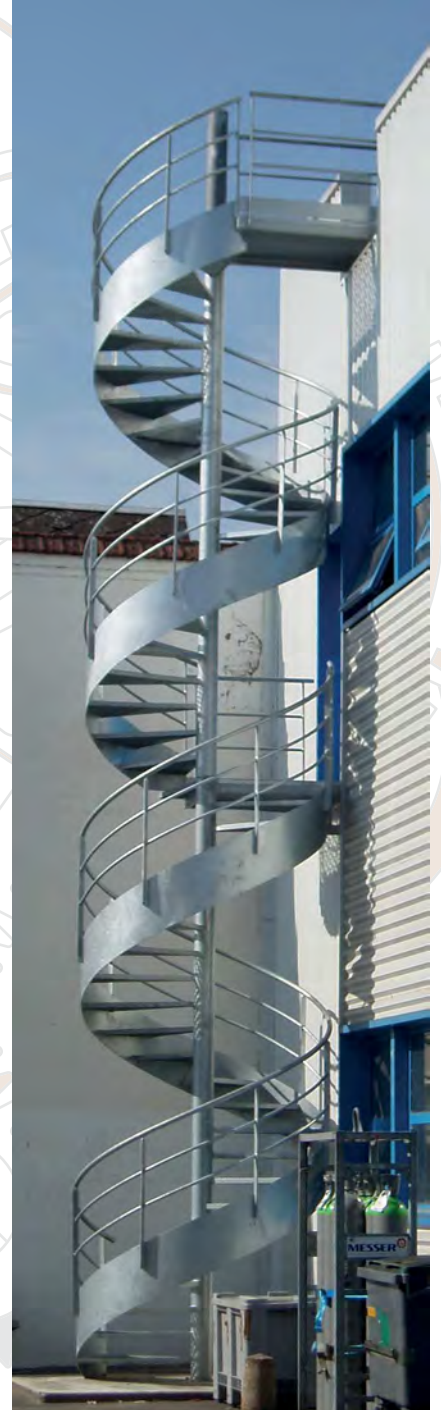
Escalier de secours (Caudebec les Elbeuf)
