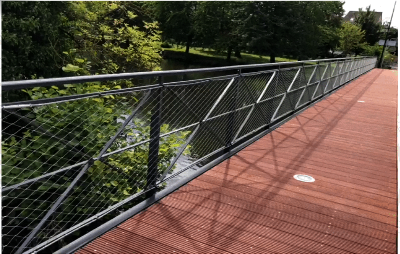
Élargissement de pont structure métallique et platelage bois ( St Lubin)
