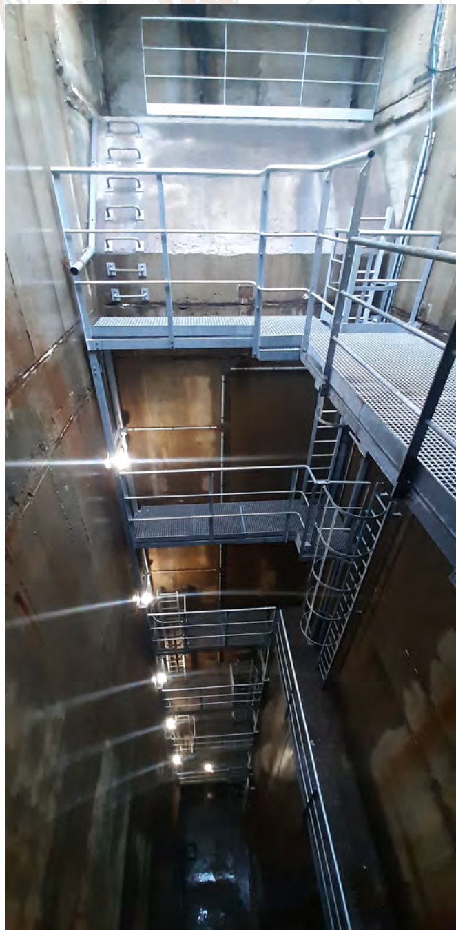
HAROPA remplacement accès syphon hauteur 25m
