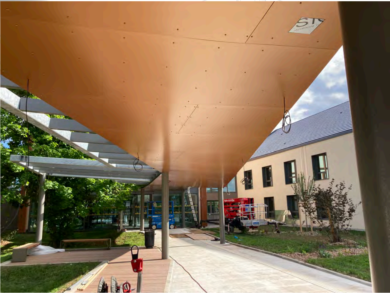
Auvent avec sous face aluminium ( Tournan en Brie)
