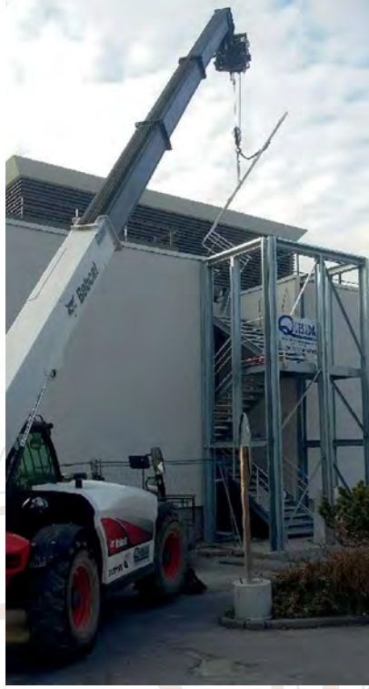
Charpente métallique escalier (Soissons)
