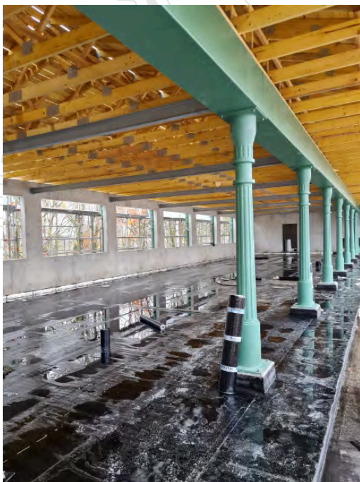
Support de charpente avec poteaux fonte ( moule appartenant à Quesada)
